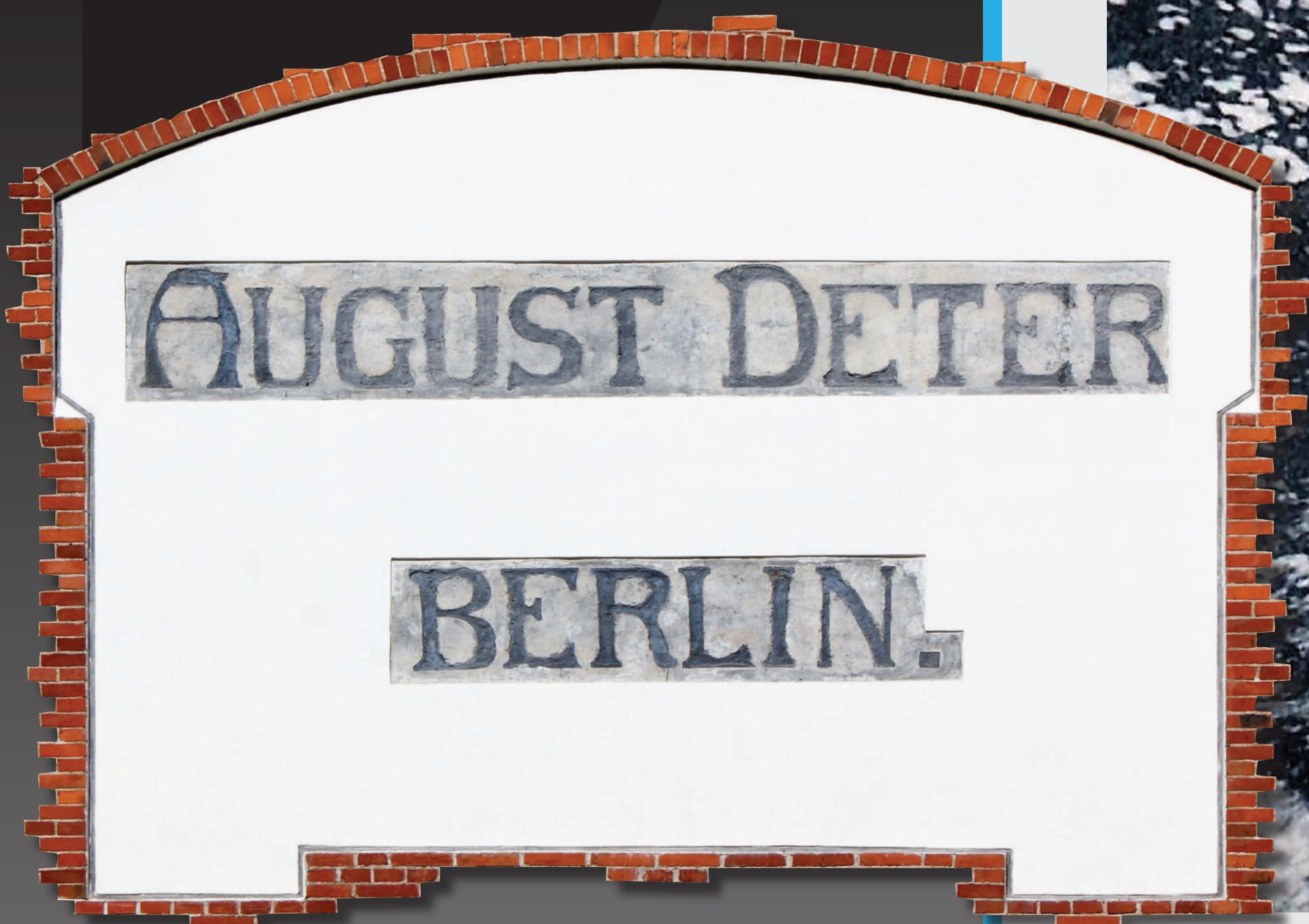
Nazwa firmy Augusta Detera znajdująca się na fasadzie budynku, w którym mieściła się fabryka cygar [fot. Sebastian Ruszała]
