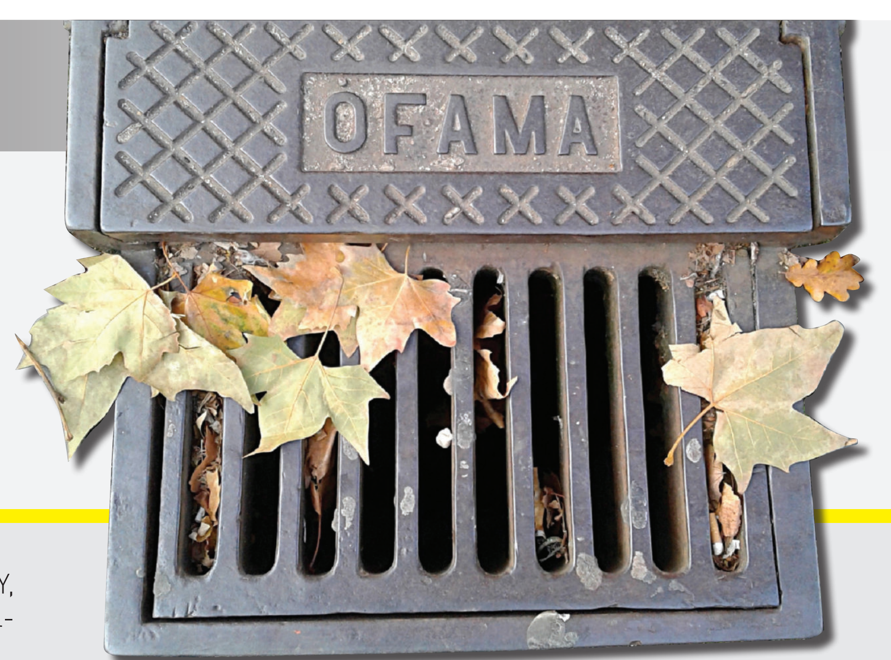
Kratka ściekowa odpływowa fabryki OFAMA [fot. Magdalena Knieja]
